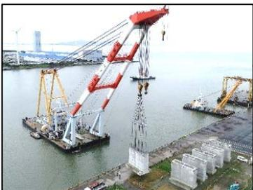
③陸上で製作したケーソン(フロー①)を起重機船で運び、土台(基礎)の上に据え付けます
