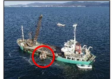
②石運搬船(ガット船)から海底に石を投入後、潜水士が石を平らになりし、土台(基礎)を作ります
