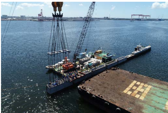
ケーソン据え付け状況
