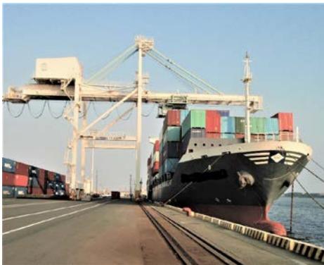
コンテナの荷役状況 (ガントリークレーン)
