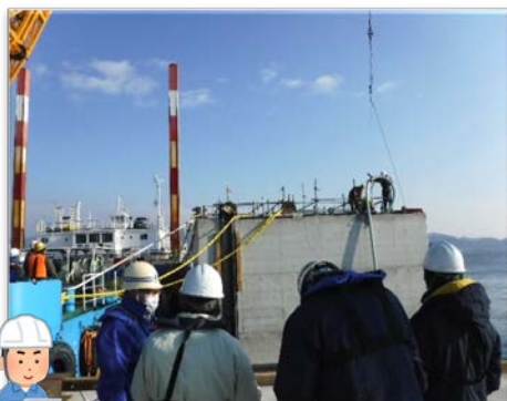
ケーソンの据付状況
