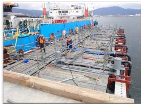
ケーソン据付完了
