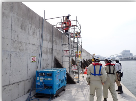
安全パトロールの様子
