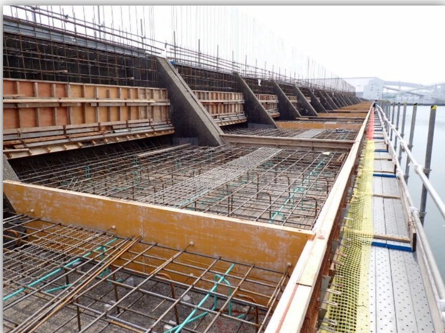
転落防止柵などが設置された型枠組立状況
