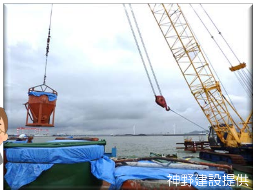
クレーン付台船を使用したケーソン据え付け工事の様子
