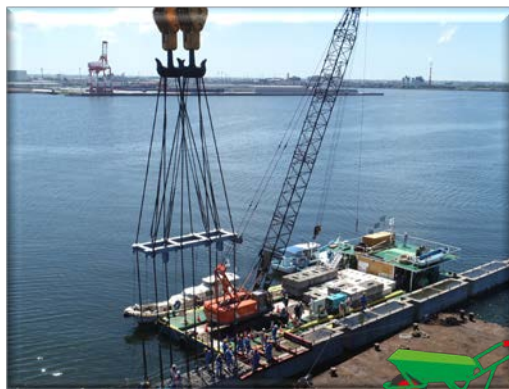
クレーン付台船を使用したケーソン据え付け工事の様子
