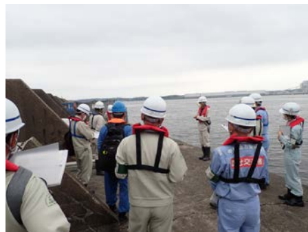
工事安全パトロールの様子
