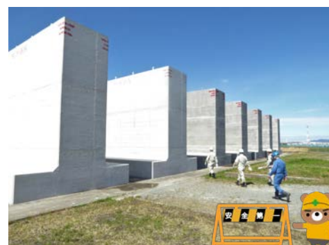
製作したケーソン
