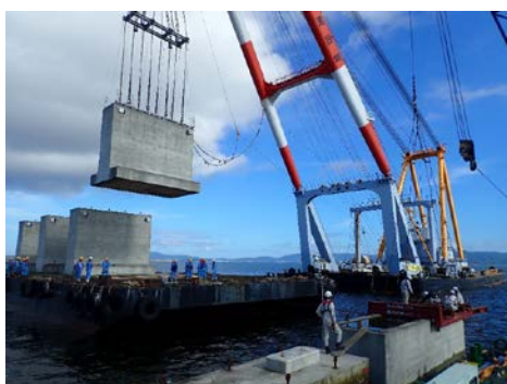
ケーソン据付の様子
