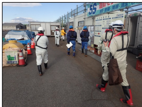
工事安全パトロールの状況（岸壁上）
