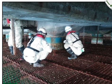
工事安全パトロールの状況（岸壁下）
