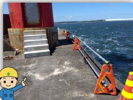
転落防止柵の設置後
