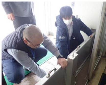
止水版の設置確認
