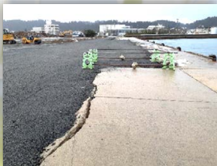
被災した岸壁の応急復旧
