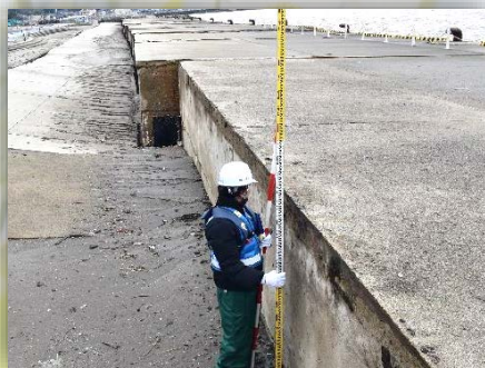
発災後の現地調査
