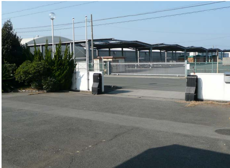
【事務所浸水前(正門)】
