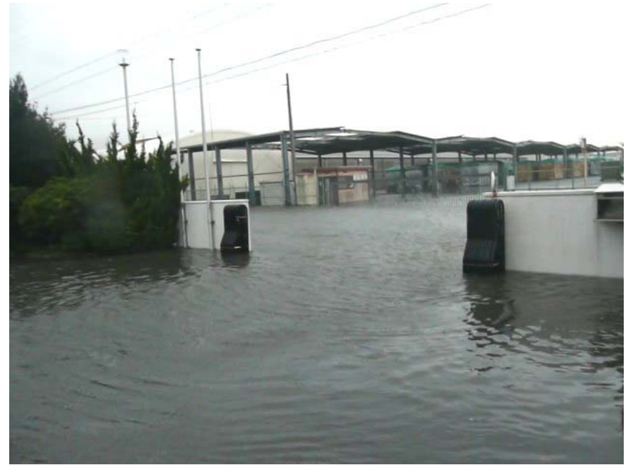
【10/8 事務所浸水状況(正門)】
