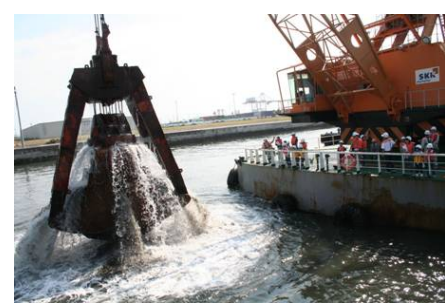
浚渫作業の見学
