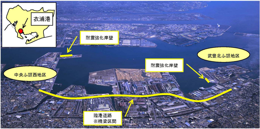
衣浦港(武豊北ふ頭地区・中央ふ頭西地区)耐震強化岸壁、臨港道路(橋梁区間)の整備
