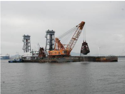
浚渫工事の様子
