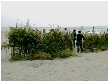
今回設置した堆砂垣
