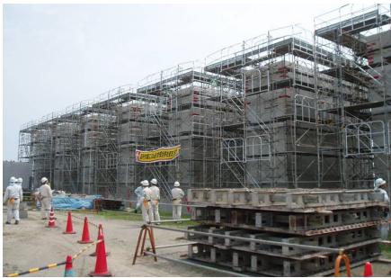
三河港のケーソン製作工事の現場
