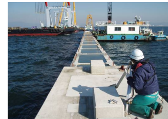
防波堤（北）工事状況 奥側が延長工事分
