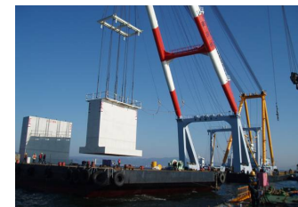
ケーソン据付状況
