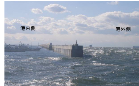
港外側と港内側での波の状態の比較
