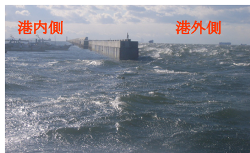
港外側と港内側 波の状態の比較
