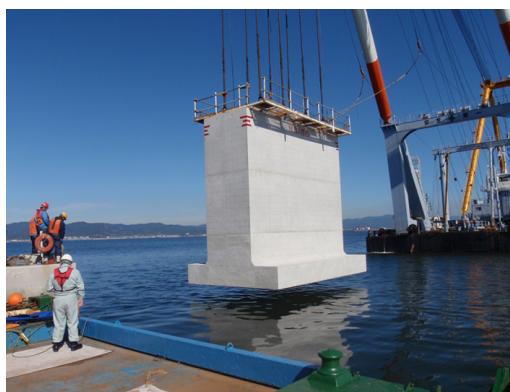
ケーソン据付状況
