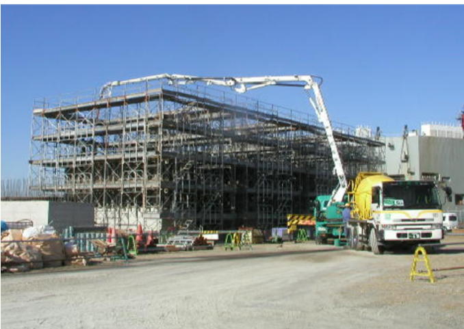
コンクリート打設状況
