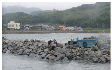
捨石均し状況
