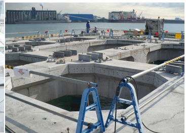
栈橋撤去作業
