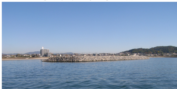
西浦町の離岸堤
