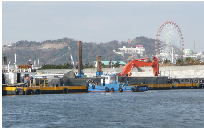
深掘跡修復工事の様子
