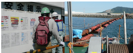
掲示板の点検の様子
