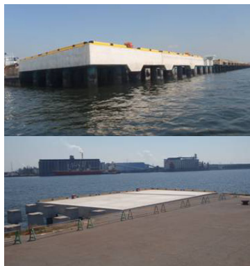
改良中の岸壁の写真
