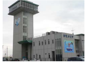
ペイントされたカモメリア外壁
