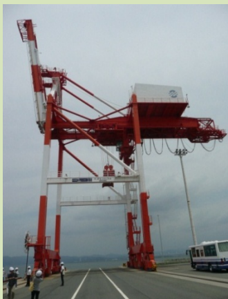
クレーン全景
