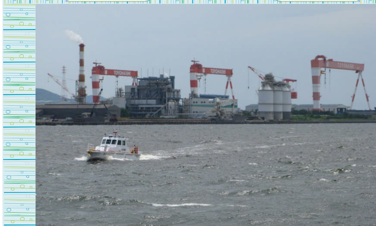
作品No11 港にいる力持ち (3基のポータルクレーン)
