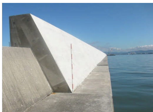
嵩上げ後の防波堤
