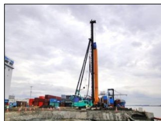
地盤改良施工状況
