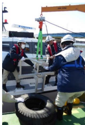
取付架台の設置
