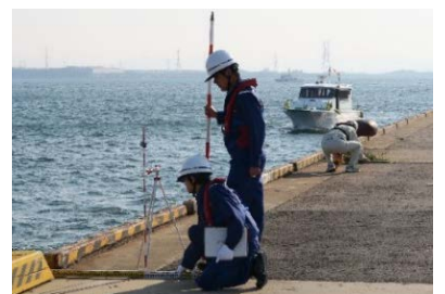
岸壁の被災状況点検の様子
