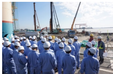
岸壁地盤改良工事について説明
