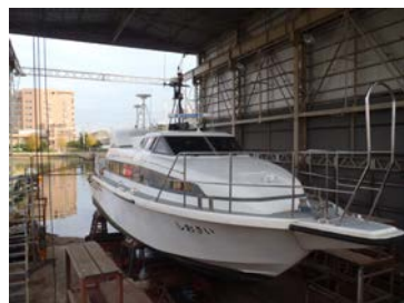
定期検査修理の様子
