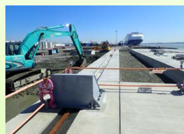
三河港神野ふ頭地区の 岸壁の改良工事
