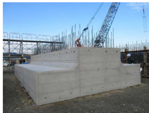
【防波堤】ケーソン製作工の写真
