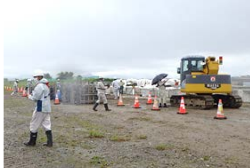
安全パトロールの様子
