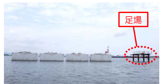
ケーソン据付後 (据付時は写真右側の足場から測量を実施)
