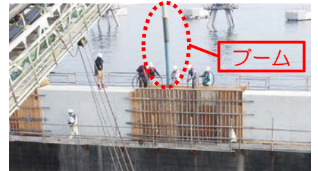
型枠内部にコンクリートを投入
