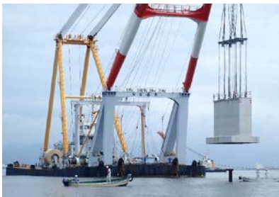
ケーソン据付の様子
