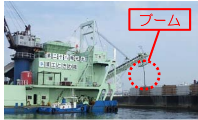
管(ブーム)から コンクリートを放出
