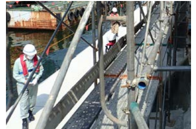
防波堤上パトロールの様子
