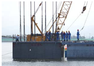
ケーソン据付完了まで cm単位での調整を実施
