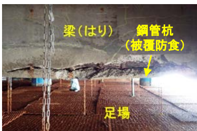
岸壁下部の様子(干潮時)
